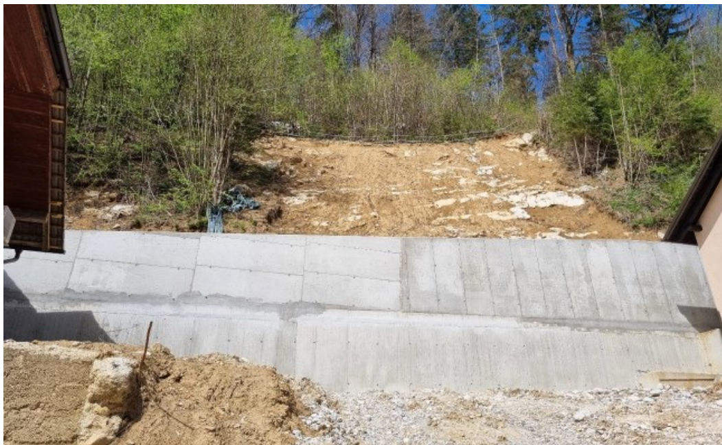
Slika 2.5: Pogled na območje plazu in že saniranega opornega zidu – pogled od spodaj navzgor
