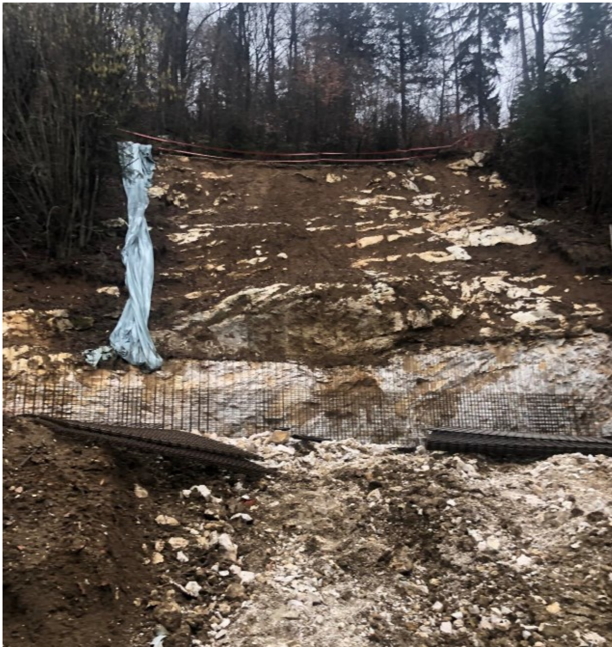
Slika 2.4: Podporni zid nad stanovanjskim objektom 12a (levo) in splazeli material med stanovanjsko hišo Stahovica 12a in 13
